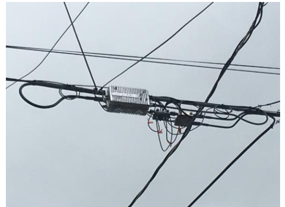
Amplificador de señal y taps de distribución de Cabletica, dentro del Condominio Praga.
