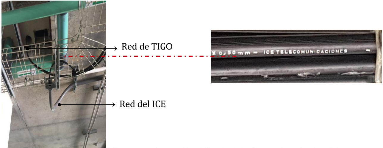
Figura II. Condominio Vive Tibás: Canalización e ingreso de la red de telecomunicaciones del ICE, 06 de setiembre, 2017.
