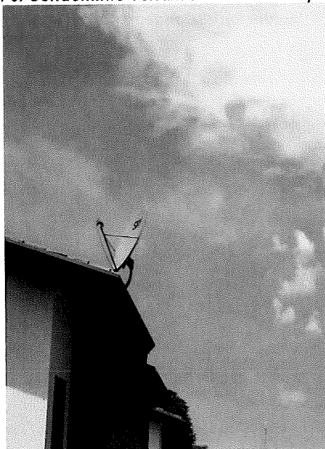
Ilustración 6. Condominio Terrazas del Oeste Etapa III. Antena de SKY.
