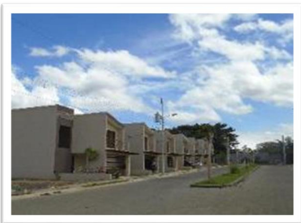
Fuente: Información recopilada en las inspecciones.
