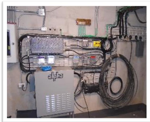
Fuente: Información recopilada en las inspecciones
