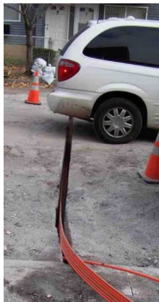
Figura 15. Las microzanjas provocan menos interrupciones de tráfico
