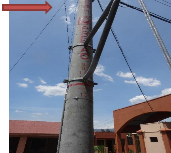
Ilustración 1. Condominio Avicennia Norte. Poste de ingreso.
